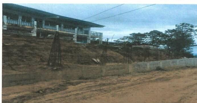
Foto 4: Se mejorará el muro de contención de lado de acceso de la escuela.
