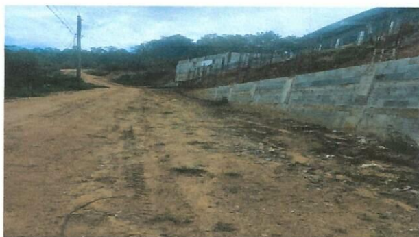
Foto 3: Se mejorará el muro de contención de lado de acceso de la escuela.
