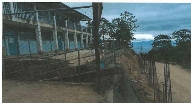
Foto1: Se mejorará el muro de contención de lado de acceso de la escuela.
